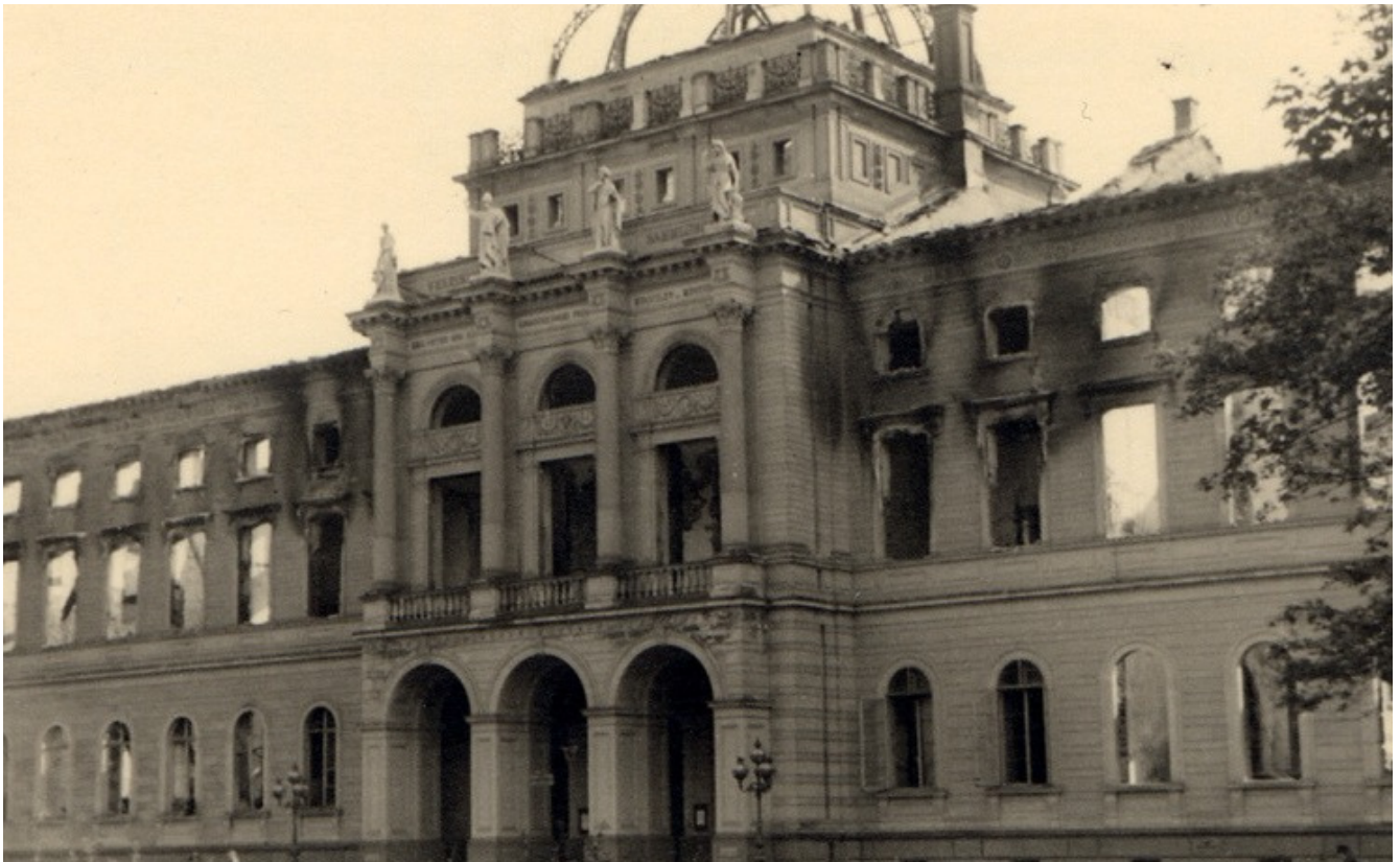
Museumsgebäude nach dem Luftangriff 1942. Foto: © Naturkundemuseum Karlsruhe
